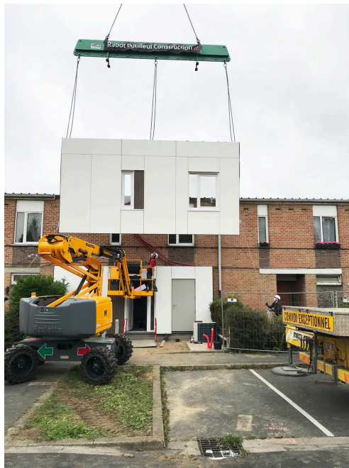
Rénovation énergétique en hors-site à Wattrelos, France ©RedCat architecture
